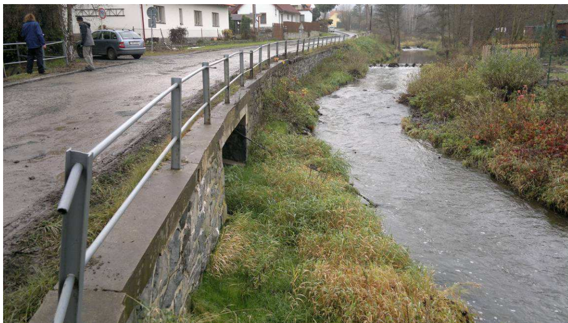
Obr.27. Pohled proti vodě na nakloněnou opěrnou zed' v ř.km 19,650
