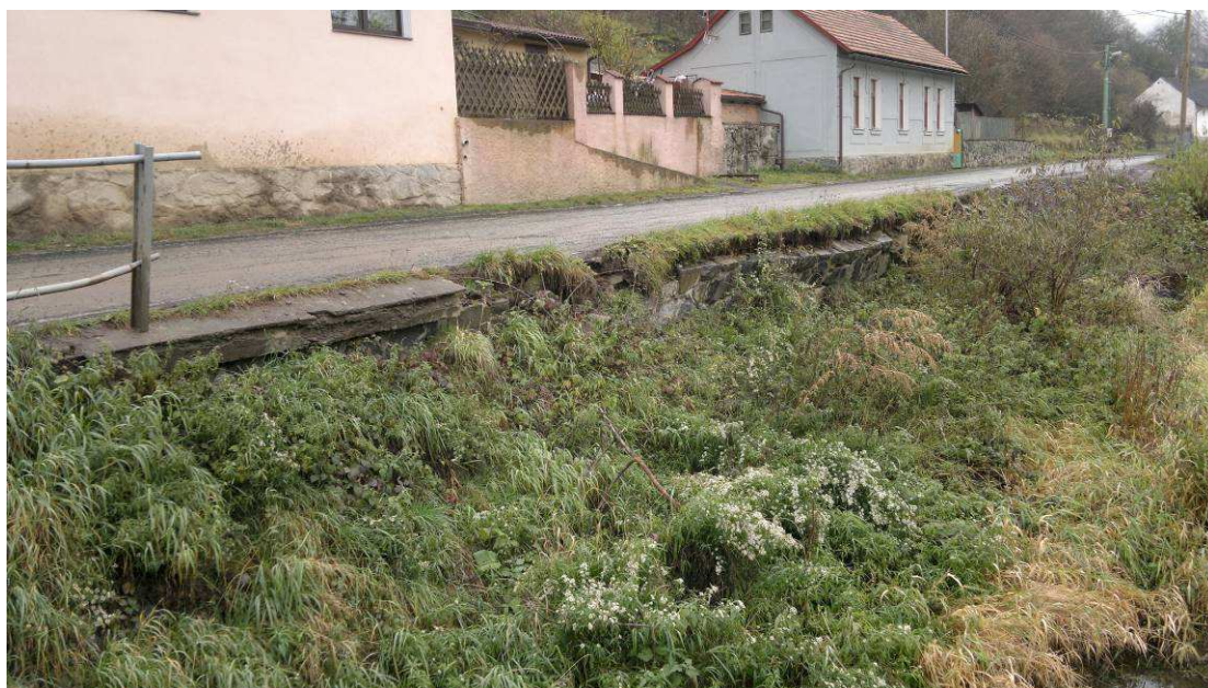
Obr.22. Nakloněná zeď a zábradlí pod sjezdem do koryta v ř.km 19,345
