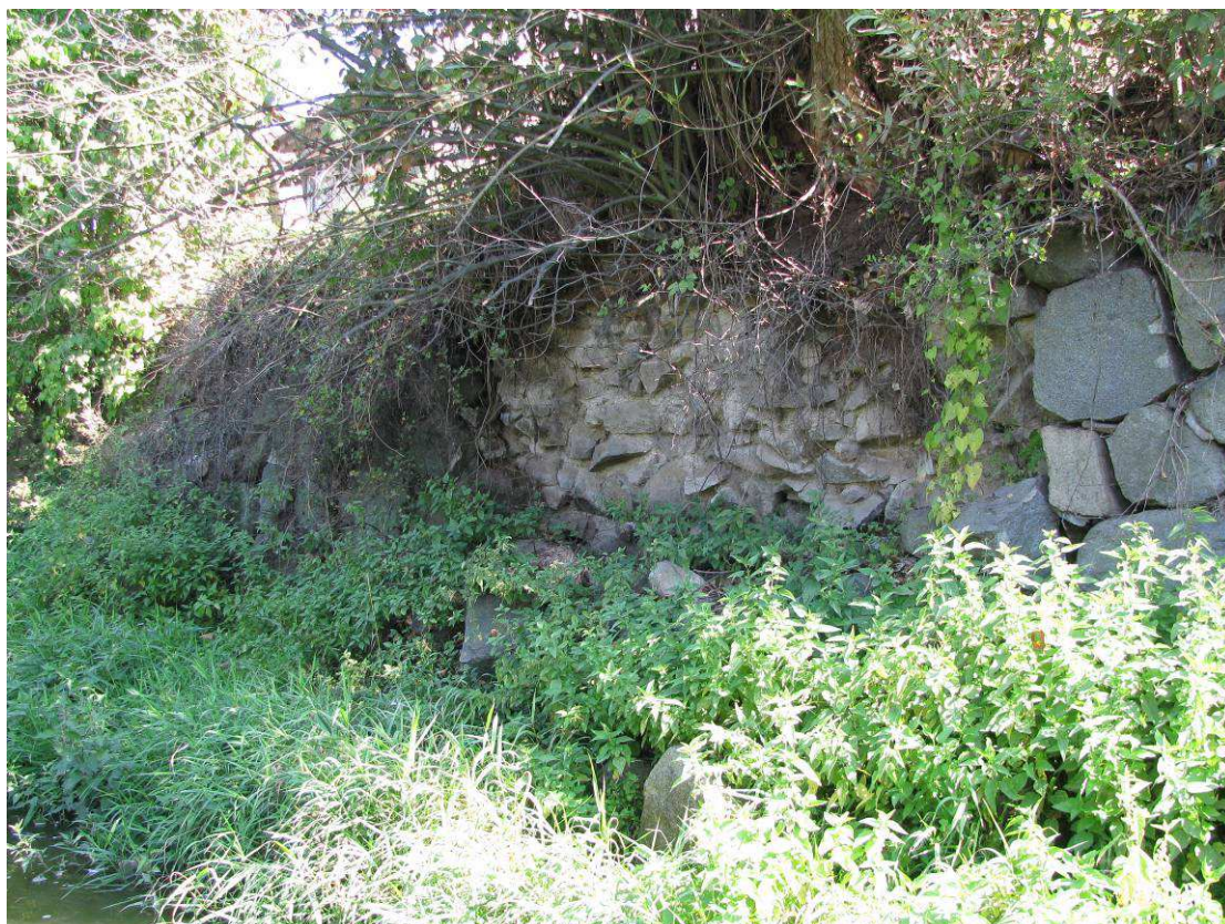
Obr.13. Porušená pravobřežní opěrná zed' v ř.km 18,928
