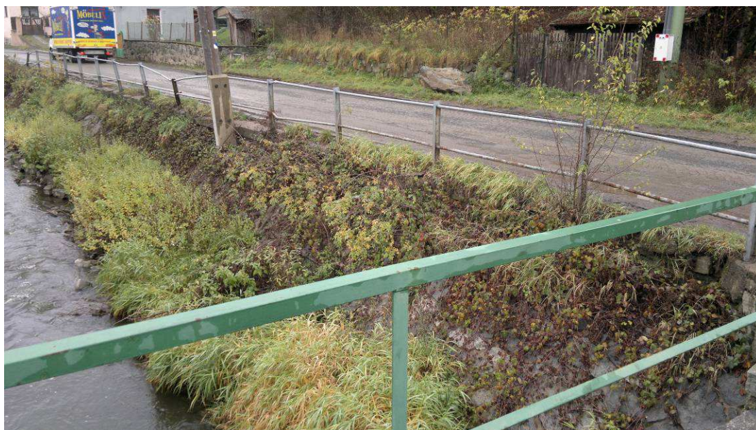
Obr.24. Poškozený pravý břeh a zábradlí pod lávkou v ř.km 19,420
