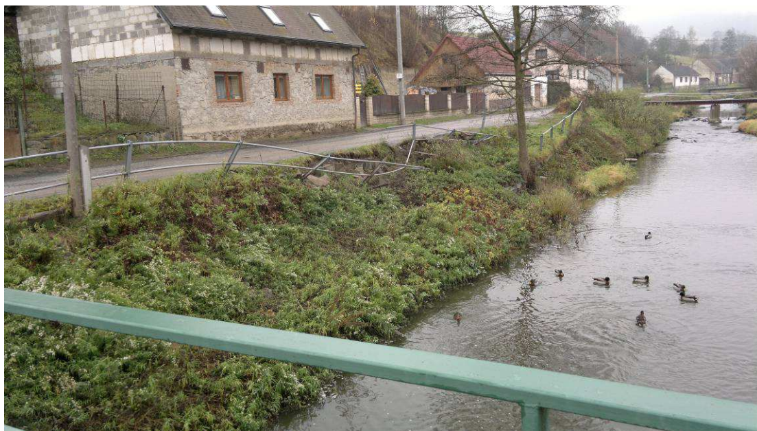
Obr.20. Nakloněná zeď a zábradlí u sjezdu do koryta v ř.km 19,280
