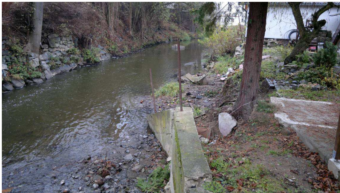
Obr.9. Pohled po vodě na poškozenou pravobřežní opěrnou zed' v ř.km 18,710
