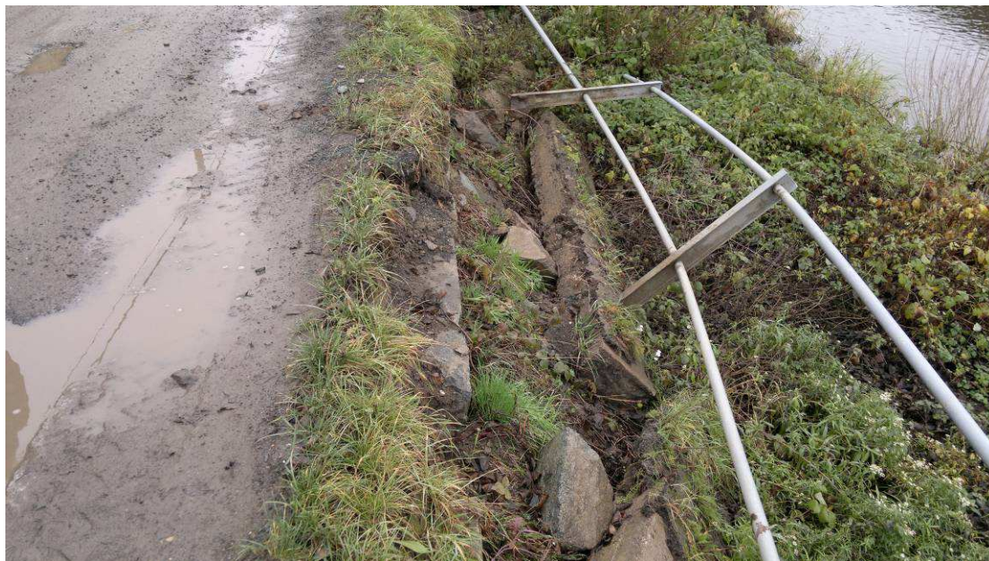
Obr.21. Detail poškozené koruny zdi u sjezdu do koryta v ř.km 19,280
