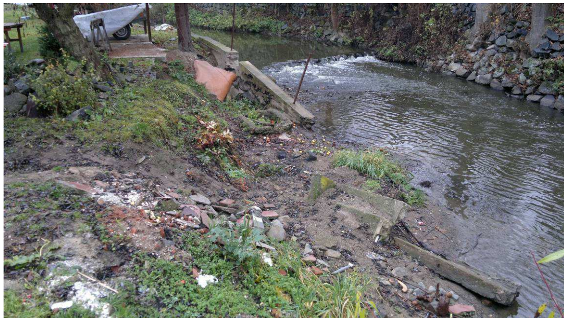
Obr.8. Pohled proti vodě na poškozenou pravobřežní opěrnou zeď v ř.km 18,710
