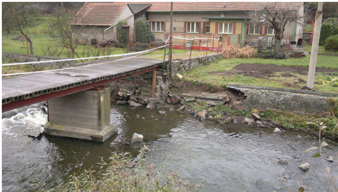
Obr.23. Poškození levého břehu pod lávkou v ř.km 19,331
